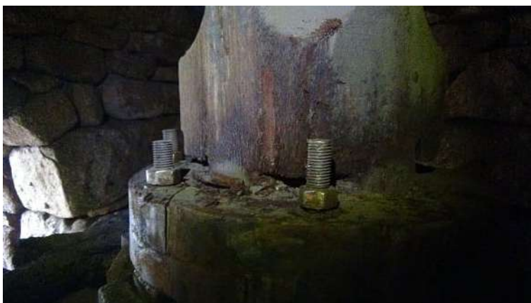
L'axe vertical ci-dessus avant démontage de la lanterne. Photo: A. Carsenat
