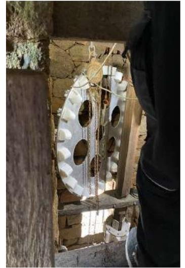
*Mise en place du rouet (partie mâle de l'engrenage) dans le puits du moulin*
