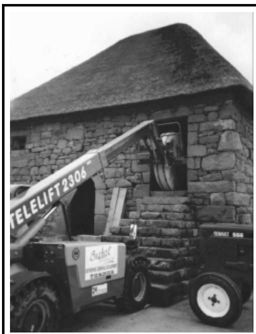
Passage délicat : la flèche de la grue est en bout de course et il n'y a que quelques centimètres de chaque côté !
