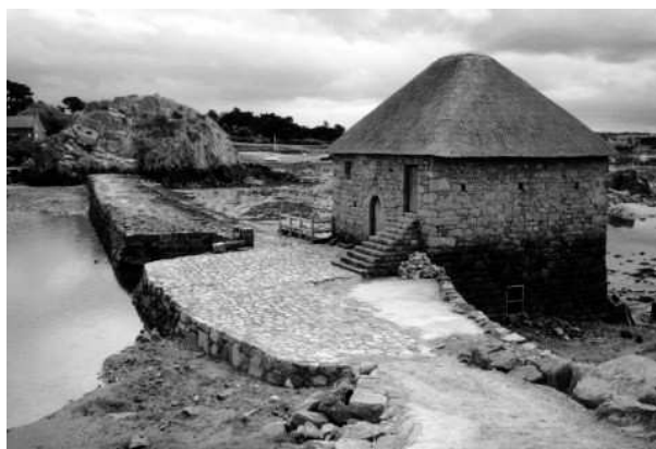
On distingue au premier plan la rive refaite du perré ainsi que le parvis. Reste la surface à droite de l'escalier et la descente d'accès dont le béton a été posé sur un film plastique.
